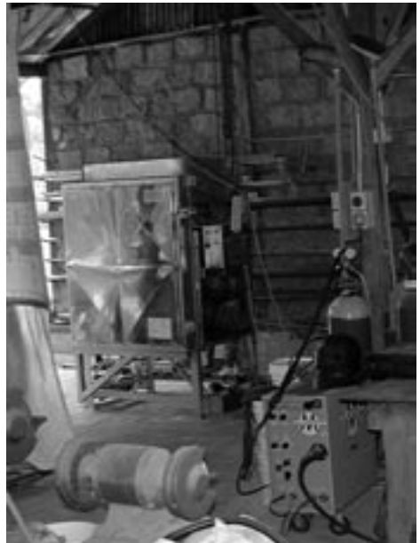
Gasofen im Bau
